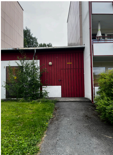
Inngang til boder og tilfluktsrom.
